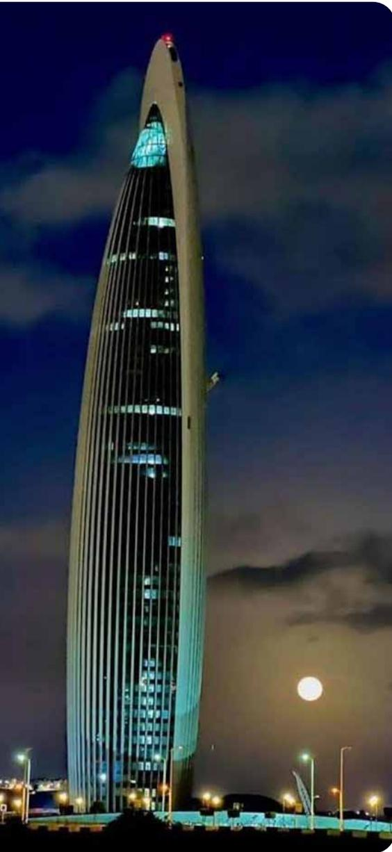
Le contreventement est assuré à %70 par le noyau en béton et à %30 par la structure des portiques en acier de la façade.
